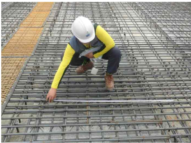
슬래브 상면철근 배근간격측정
