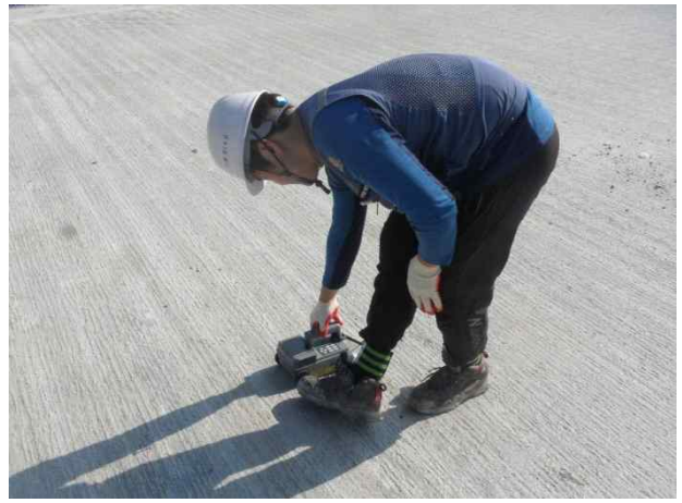
6S(상주방향) 슬래브 상면 철근배근탐사 전경
