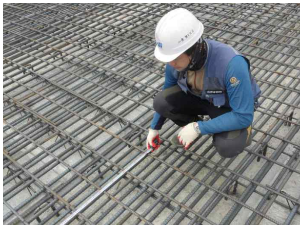
슬래브 상면철근 배근간격측정
