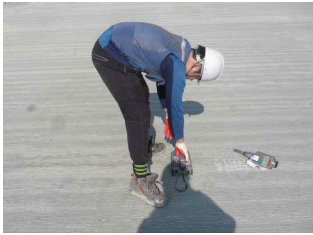
5S(상주방향) 슬래브 상면 철근배근탐사 전경
