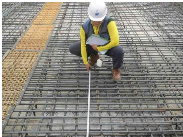
슬래브 상면철근 배근간격측정
