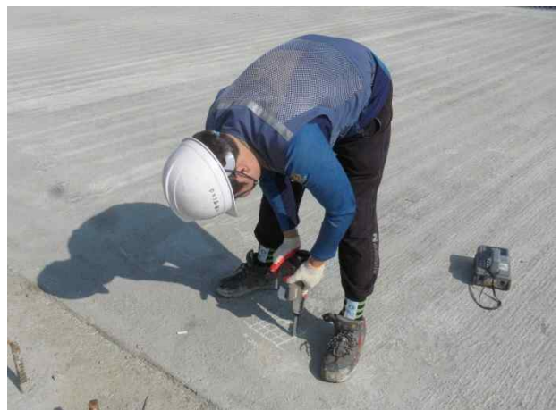
6S(상주방향) 슬래브 상면 반발경도시험 전경
