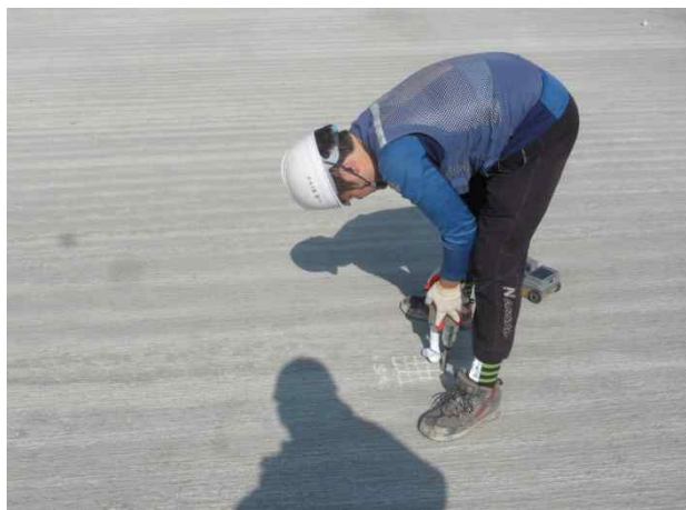
5S(상주방향) 슬래브 상면 반발경도시험 전경
