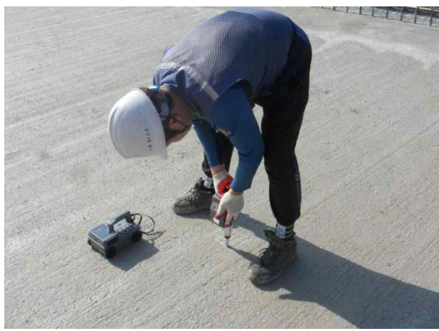
1S(영천방향) 슬래브 상면 반발경도시험 전경
