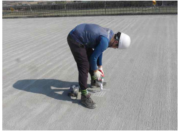
4S(상주방향) 슬래브 상면 반발경도시험 전경
