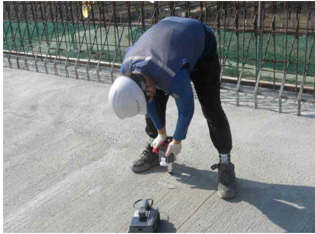
3S(영천방향) 슬래브 상면 반발경도시험 전경
