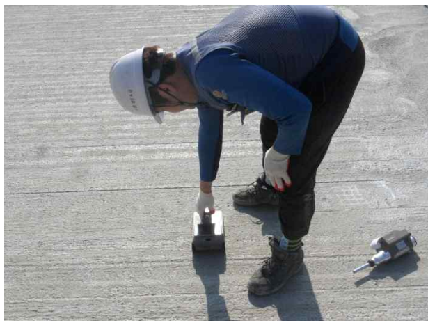
2S(영천방향) 슬래브 상면 철근배근탐사 전경
