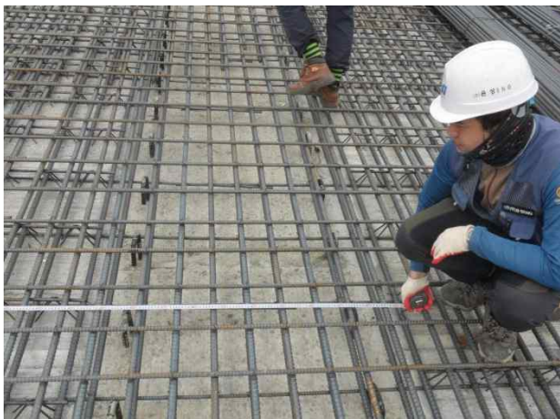
슬래브 상면철근 배근간격측정
